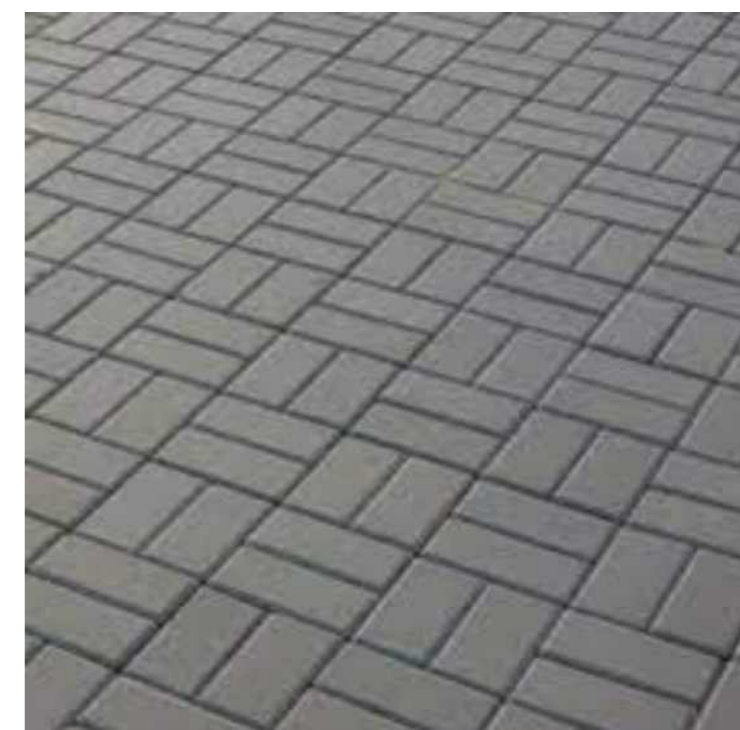
PŁYNNIE POWIĄZANIE Z UKŁADEM CHODNIKÓW SĄSIADUJĄCYCH ZA POMOCĄ TYPOWEJ NAWIERZCHNI STOSOWANEJ NA TERENIE KAMPUSU SGGW - KOSTKA BETONOWA JASNOSZARA TYPU HOLLAND W UKŁADZIE PARZYSTYM
